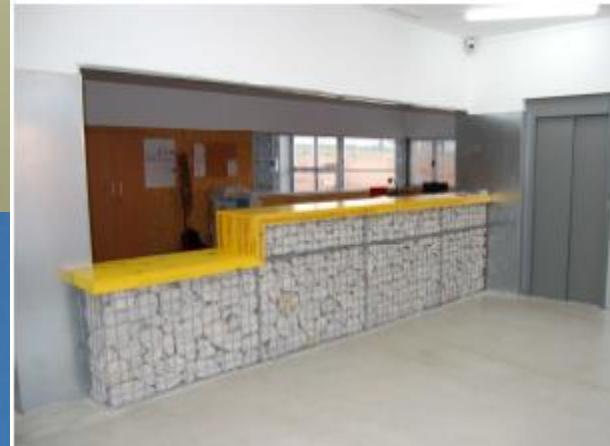
Gavión de Revestimiento.
