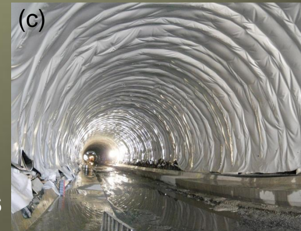
INTERIOR DE TÚNELES
