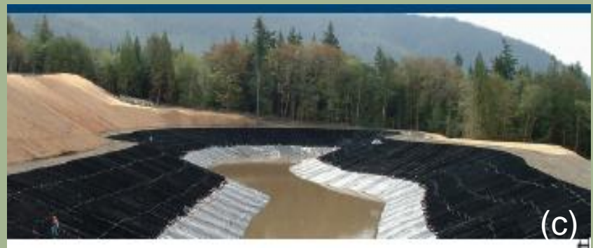
Tratamiento de Taludes
