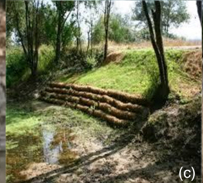
Ejemplo de Muro Kraïner 1
